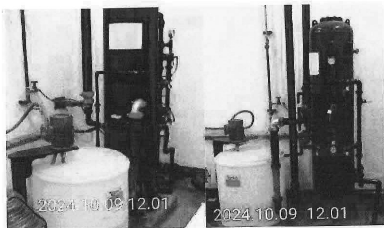
ภาพประกอบที่ 7 อุปกรณ์ระบบกรองน้ำร้อน
