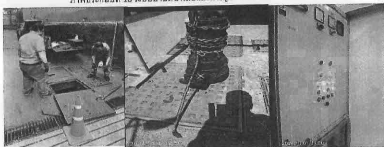
ภาพประกอบที่ 19 เครื่องสูบน้ำและชุดควบคุมจำนวน 2 ชุด
